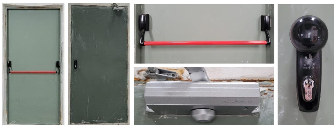
Vistas del modelo y detalle del herraje
