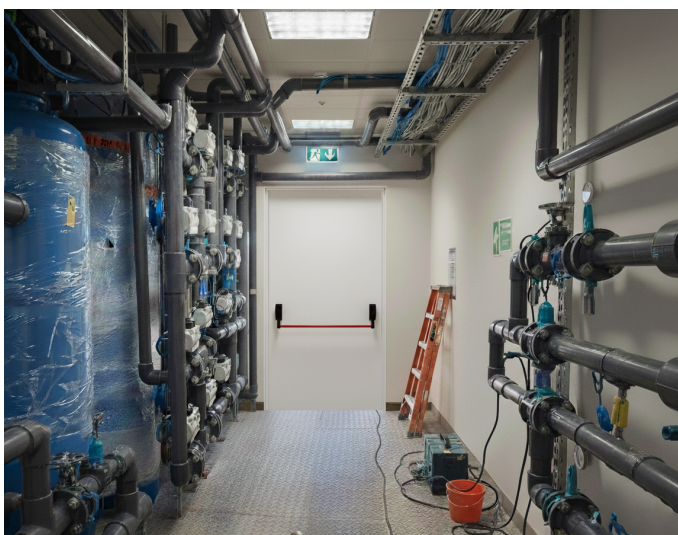
Salida de emergencia en edificio industrial.
